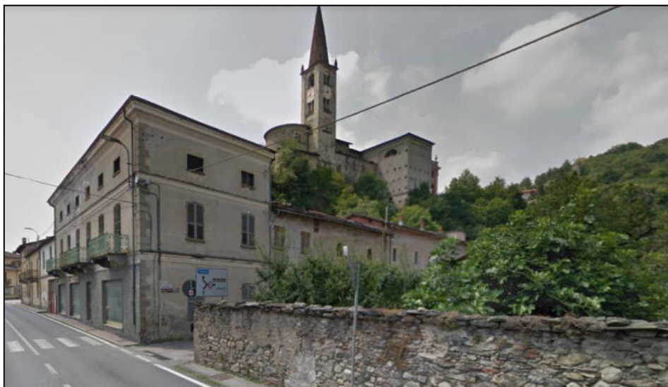
Vista in direzione sud da Via Matteotti
